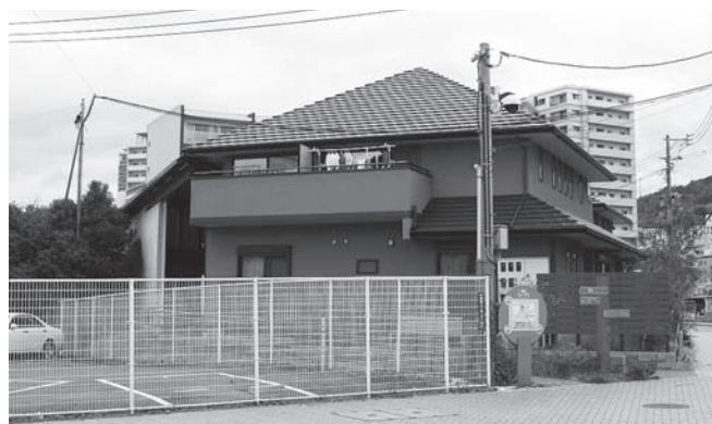
1kW級7台を実証中の集合住宅
