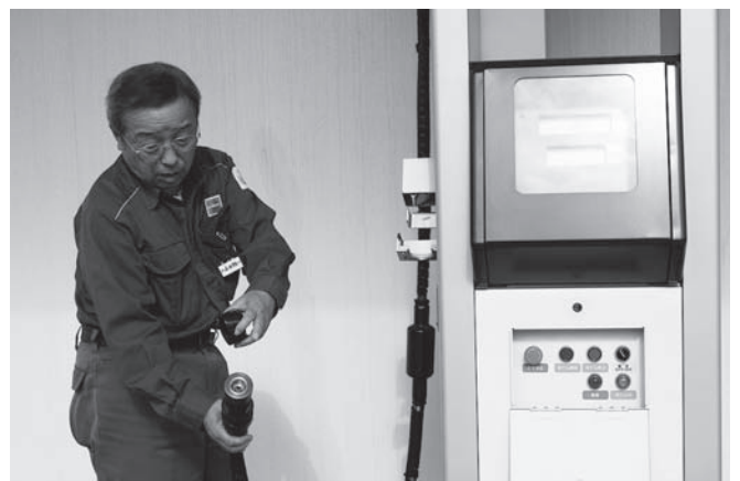
水素ステーションの水素を充てんするディスペンサー。圧力35MPaで連続3台分充てん可能
