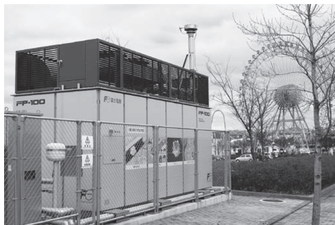
いのちのたび博物館に導入された富士電機製 100kWリン酸形燃料電池
